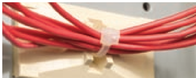
Uchycení pomocí samolepicí patky
